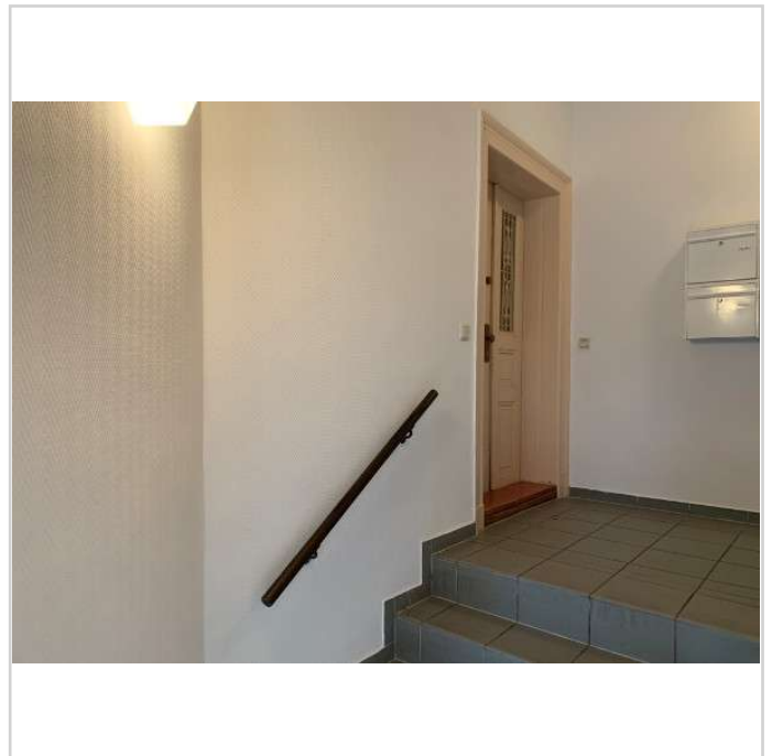
2020-01-07 EG li Treppenhaus
